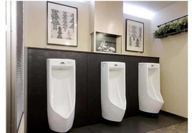
床の清掃性に優れた壁掛自動洗浄小便器を採用。足元と腰壁には、防汚・防臭機能を備えたハイドロセラ・フロアとハイドロセラ・ウォールを設置。中央には創業者の宝物であるハーレーの模型が飾られている。
