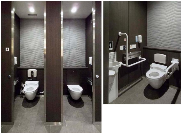
男性トイレ 大便器ブース
