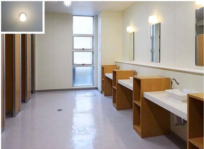
7号館1F女性トイレ 改修後
