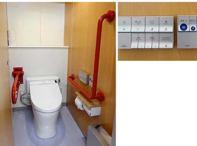
7号館3F女性トイレ 手すりつきブース
