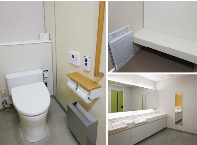
図書館棟 2F・3F女性トイレ
