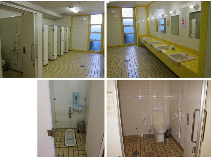
7号館1F女性トイレ 改修前
