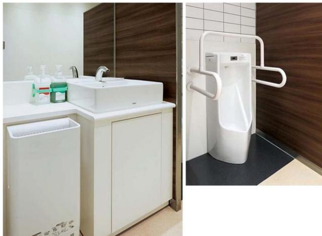
洗面カウンターの一部を切り欠いてクリーンドライをすっきり納めている。小便器の足元には、尿の飛散によるにおいや汚れを軽減する、ハイドロセラフロアPUを設置。
