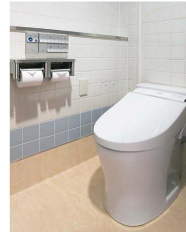
八事フランテ同様、大便器は連続洗浄ができるフラッシュタンク式を採用しウォシュレットを設置。リモコンはボタンを押すたびに発電し、乾電池交換や電源工事が不要なエコリモコンを採用。
