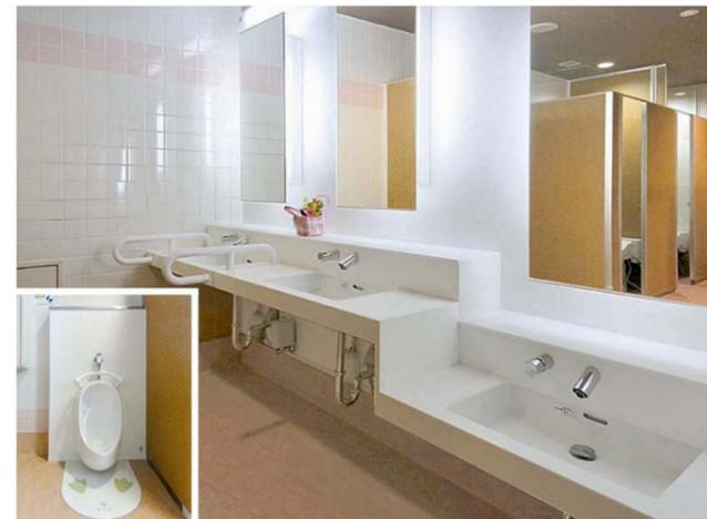
小さなお子様連れに配慮して、1ヶ所の洗面器は570mmの高さに設置。幼児用小便器の足元には、尿の飛散によるにおいや汚れを抑制するハイドロセラフロアキッズを設置している。
