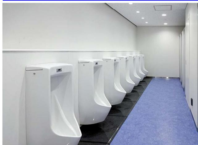
小便器は、床の清掃性に優れた壁掛式の低リップタイプ小便器を採用。足元には、尿の飛散によるにおいや汚れを軽減するハイドロセラフロアPUを設置している。
