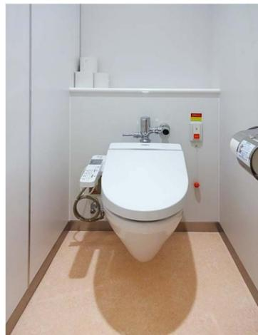
大便器は床の清掃性に優れた壁掛式を採用し、2度流しを防止する音姫(擬音装置)機能を搭載したウォッシュレットを設置。防犯対策として呼出ボタンも完備している。
