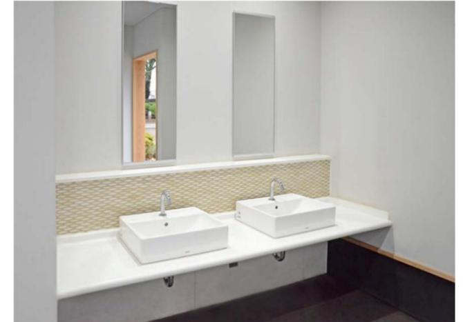
洗面器は、スクエアな形状が特長のベッセル式を採用。水栓金具は、ノンタッチで水の出し止めができ、止め忘れがない自動水栓を設置している。
