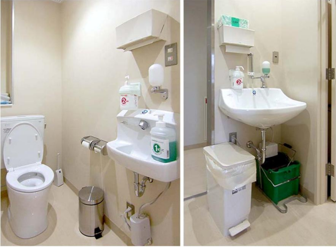
給食室 トイレ
