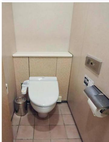
すべての大便器にウォシュレットを設置。プライバシーの配慮と2度流しを防止する、音姫（擬音装置）も設置している。
