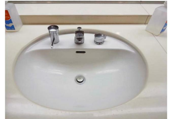
水栓金具は、ノンタッチで水の出し止めができる自動水栓（サーモスタット）とムースタイプのソープディスペンサーを設置している。
