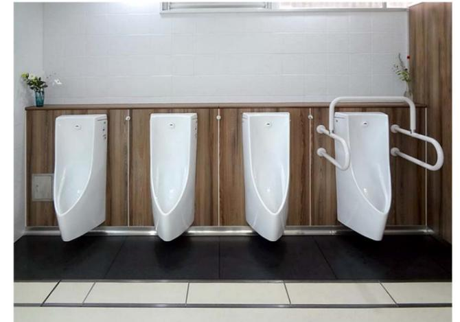
床の清掃性と節水性に優れた壁掛式の自動洗浄小便器を採用。自己発電タイプなので停電時にも使用することができる。足元には、尿の飛散によるにおいや汚れを軽減するハイドロセラフロアPUを設置。
