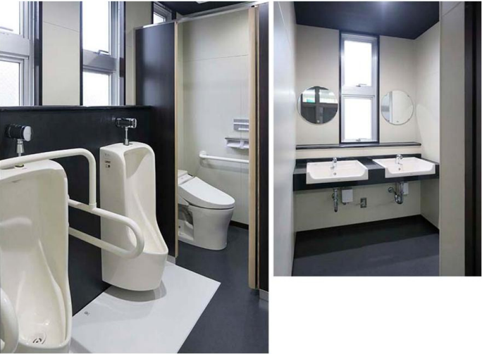
男性職員トイレ 全体
