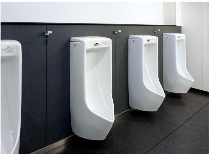
小便器は、床の清掃性に優れた壁掛式を採用。足元には、尿の飛散によるにおいや汚れを軽減するハイドロセラ・フロアを設置。小便器の間には、荷物や傘などが掛けられるフックを設置している。
