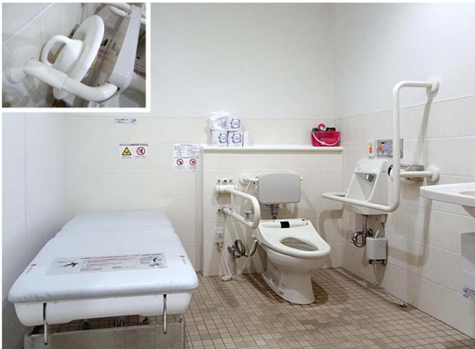
訓練用トイレ 車いす対応ブース
