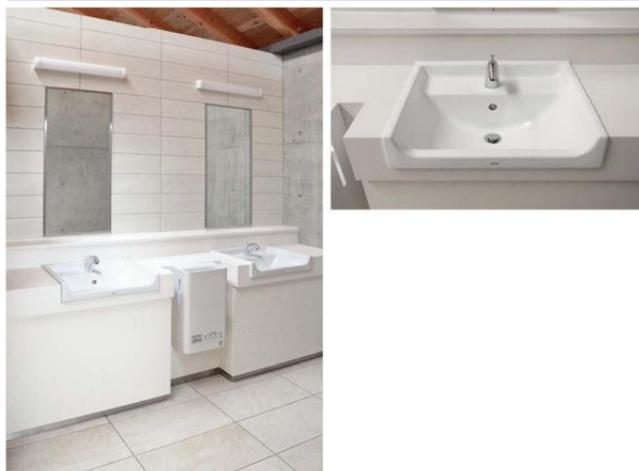
洗面器は、カウンターへの水はねを軽減するタイプを採用。水栓金具は、ノンタッチで水の出し止めができる自動水栓を設置。洗面器の間にクリーンドライを設置し、手洗い後の床への水垂れを抑えている。
