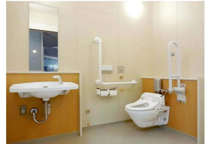
1Fには車いす使用者に配慮して、はね上げ手すりとL型手すりを備えた多機能トイレを設置している。
