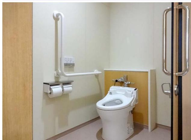
多機能トイレの機能を分散するために、1Fに多機能トイレ、2F・3Fのトイレには、ケガで松葉杖を使用する子どもたちへ配慮して、大型ブースを男女トイレに各1ヶ所設置している。
