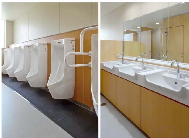
衛生面に配慮して、尿石抑制機能付きの自動洗浄小便器を採用。足元には、尿の飛散による、においや汚れを軽減するハイドロセラ・フロアを設置。洗面器には、非接触式の自動水栓を設置している。
