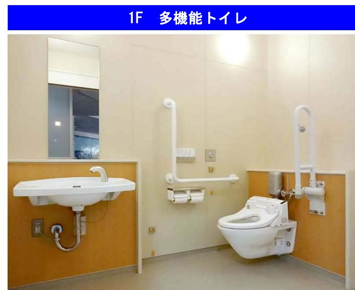
1Fには車いす使用者に配慮して、はね上げ手すりとL型手すりを備えた多機能トイレを設置している。
