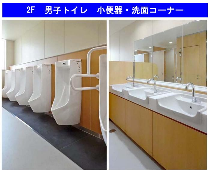
衛生面に配慮して、尿石抑制機能付きの自動洗浄小便器を採用。足元には、尿の飛散による、においや汚れを軽減するハイドロセラ・フロアを設置。洗面器には、非接触式の自動水栓を設置している。
