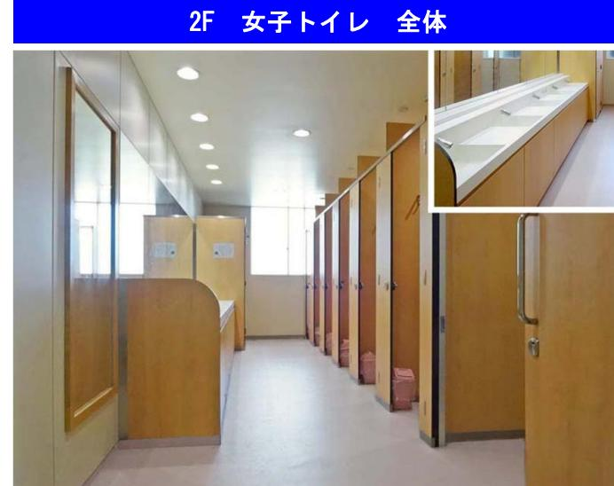
洗面コーナー横の壁には、身だしなみチェックのための全身鏡を設置。洗面カウンターは、洗面ボウルがコンパクトでボウル数を多く設置できる、ツインディッキボウル一体タイプ(奥行450mm)を採用している。
