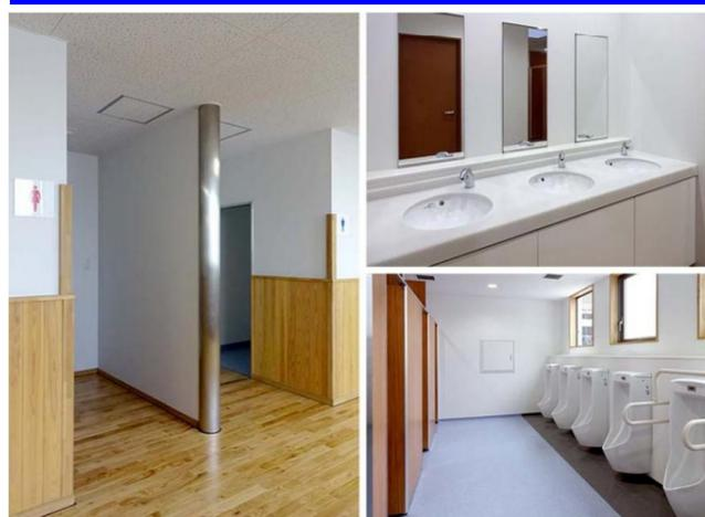
屋内運動場近くのトイレ。洗面器の水栓金具は、ノンタッチで水の出しとめができる、自動水栓を設置。小便器は尿石の付着やにおいの発生を抑制する「ジアテクト」機能を搭載したタイプを採用している。
