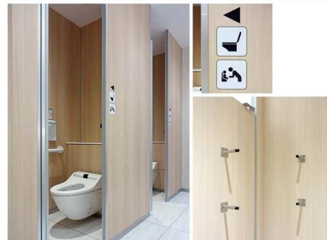
小さなお子様連れなどに配慮して、すべての大便器ブースにベビーチェアと補助便座、手すりを設置。手荷物配慮として、大便器後方に棚を設け、フックを4ヶ所設置している。
