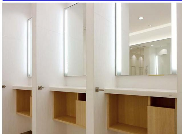
お化粧直しがしやすいよう、壁材や間仕切り材には、光の拡散効果で顔に影がでにくい、ハイドロセラ・ウォールの光拡散プレミアムホワイトシリーズを採用。手荷物を置く棚もしっかりと用意されている。
