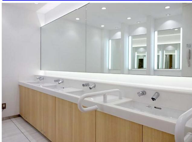
洗面カウンターは水濡れを心配せずに手荷物を置くことができるツインデッキカウンターを採用。大便器コーナー同様、洗面・パウダーコーナーの壁にも、防汚・防臭機能に優れたハイドロセラ・ウォールを採用。
