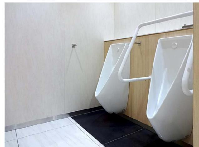
小便器も節水のための最先端技術を備えた、シンプルなデザインのRESTROOM ITEM 01を採用。手荷物配慮として、ライニングの高さを手荷物が置きやすい高さに設定し、フックを3ヶ所設置している。
