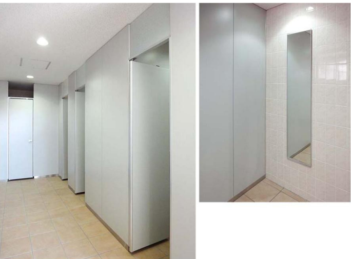
男性トイレ 大便器コーナー
