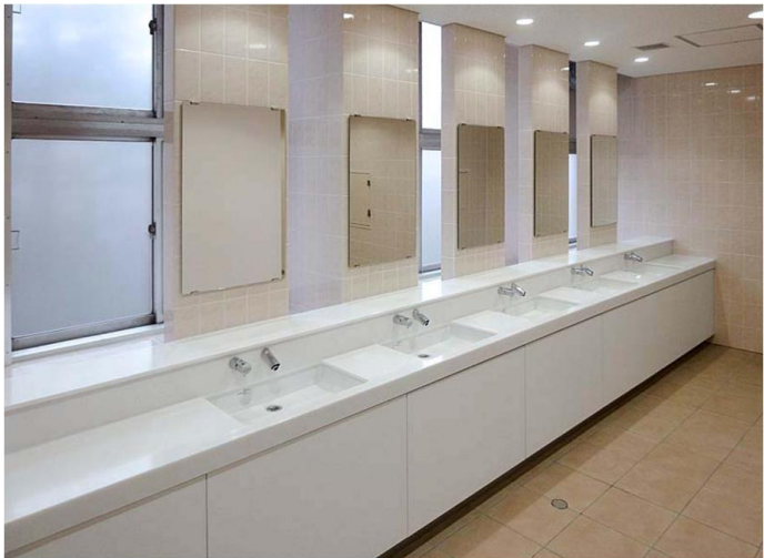
女性トイレ 洗面コーナー
