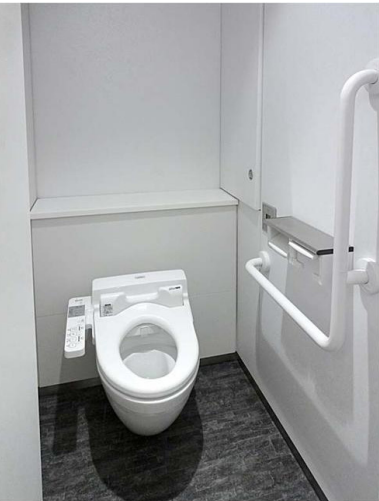
女性トイレ 大便器ブース
