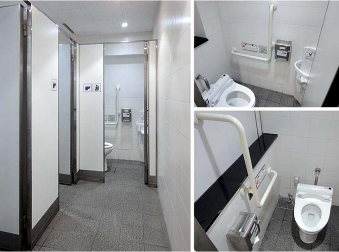
男性トイレ 大便器ブース
