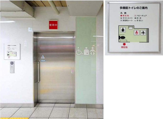
多機能トイレ 入口
