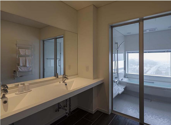
2人同時に使用できるボウル一体型の洗面カウンターを採用。床は木目調のタイル仕様としている。浴室ドアはフルスクリーンの透明強化ガラスで、浴室との一体感と開放感を演出している。
