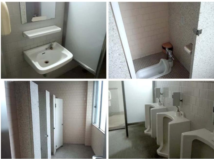
改修前トイレ
