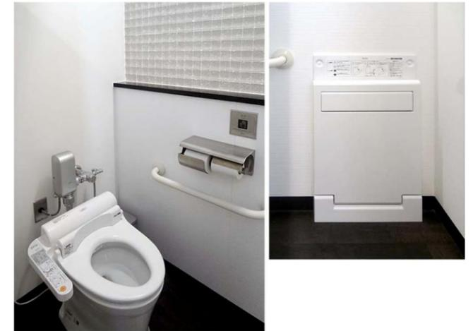
大便器ブースの壁にも50角のタイルを採用。大便器は5.5L洗浄のパブリックコンパクト便器。1ヶ所の大便秘器ブースには、ストッキングの履き替えなどができるフィッティングボードを設置している。
