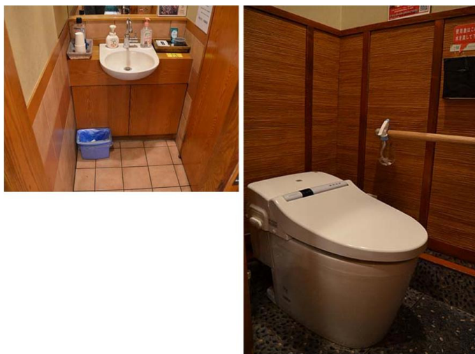
改修前トイレ
