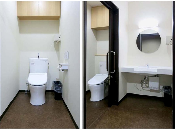
男性トイレ(写真左)と女性トイレ(写真右)。女性トイレには、カウンター奥行き450mmのコンパクトなボウル一体形洗面カウンターを採用している。
