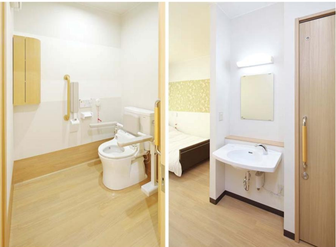
使用中の座位の安定が図れる背もたれ付きトイレアームレストと、排泄を促す前傾姿勢が保てるように前方ボードを設置。入口扉は車いすでアプローチしやすいように2枚引戸を採用している。
