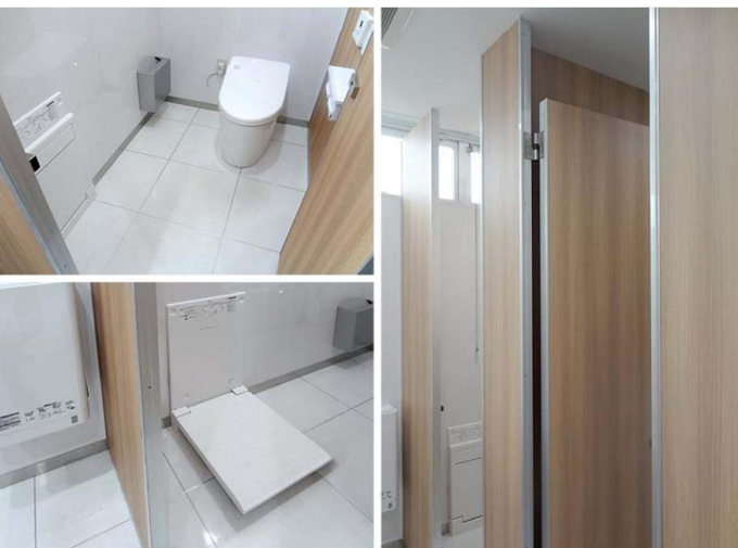
女性トイレ 大便器ブース
