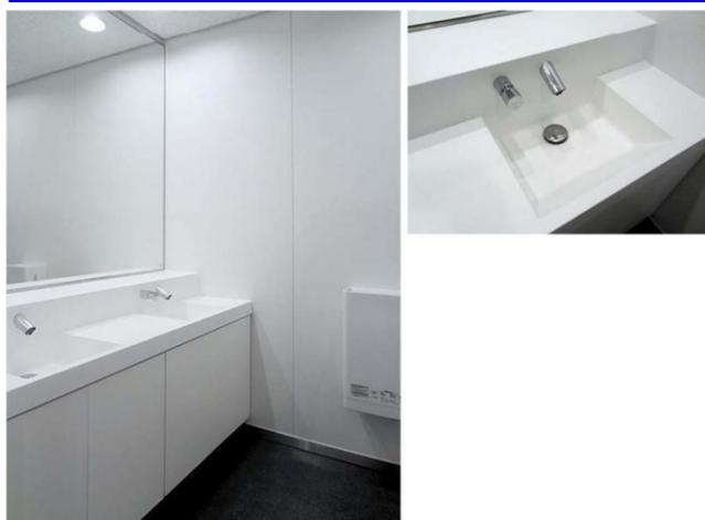
洗面カウンターは、カウンターとボウルに継ぎ目がなく、清掃性に優れたボウル一体形カウンターを採用。水栓金具は、水じまいがよい壁付きの自動水栓とプッシュ式水石けんを設置している。
