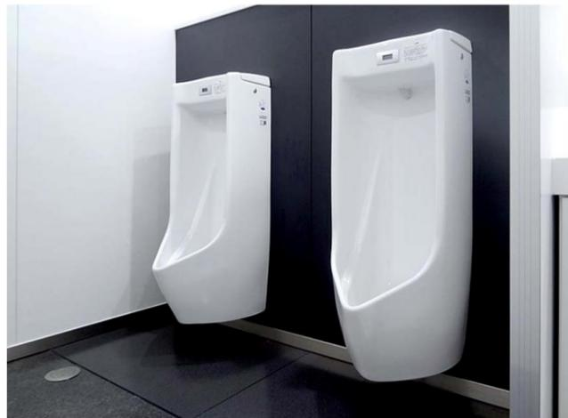
床の清掃性に優れた、壁掛式の低リップタイプ自動洗浄小便器を採用。足元には、尿の飛散によるにおいや汚れを軽減するハイドロセラ・フロアを設置している。
