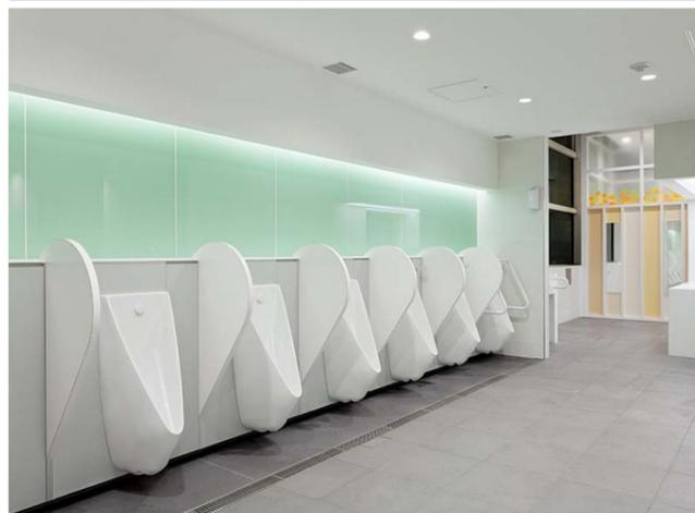
プライバシーに配慮して、小便器コーナーには間切りを設置。足元には、尿の飛散によるにおいや汚れを軽減するハイドロテクトタイルを採用。小便器下部に設けた散水装置からは、夜間に自動散水される。
