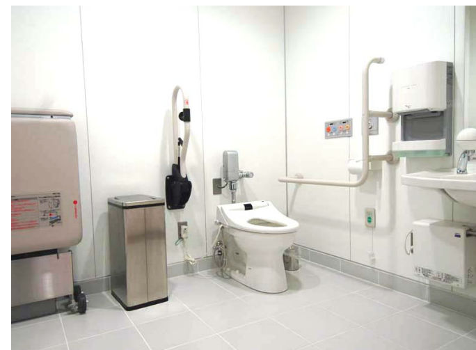
【商業】4F 多目的トイレ
