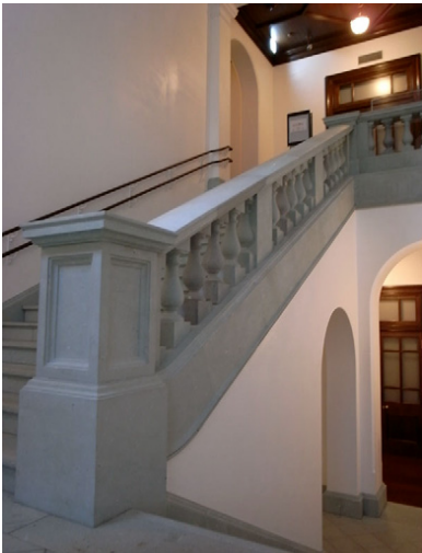
明治時代の手すりを再利用した階段。窓からは、三菱一号館広場の噴水や木々が見える。
