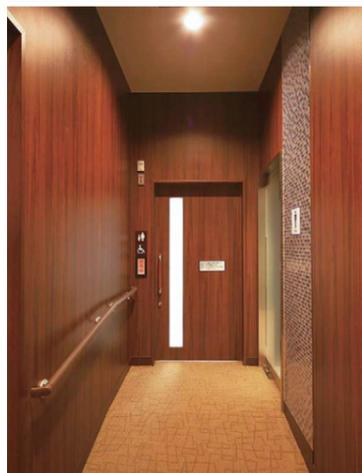
男性トイレ・多目的トイレ入口。手前に段差があったが、トイレ内の床レベルを下げ、残ったレベル差をスロープにして解消している。
