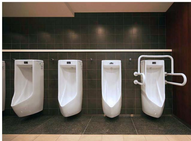
壁掛式低リップタイプの小便器と、床材には尿の飛散などに配慮した清掃性の高いハイドロテクトタイル(ハイドロセラ・フロアPU)を採用。
