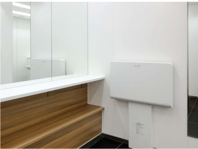
カウンターには、唐人町駅のシンボルカラーである茶色を採用した大きな荷物が置ける棚を設けた。おむつ替えができるベビーシートを併設している。
