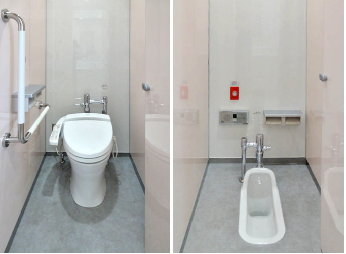
3F 女性トイレ 大便器ブース
