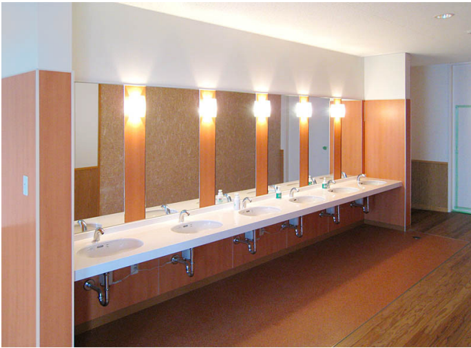
教師の要望を反映し、トイレとは別に洗面所を設置。非接触で手洗いができるよう、アクアオート（自動水栓）を採用した。
