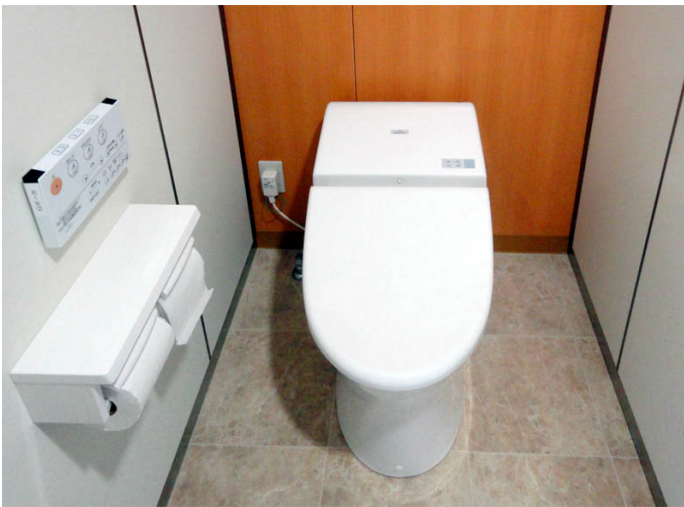
生徒にも環境を意識させることができる、4.8Lで洗浄できる節水型のウォシュレット一体形便器GGを採用。
