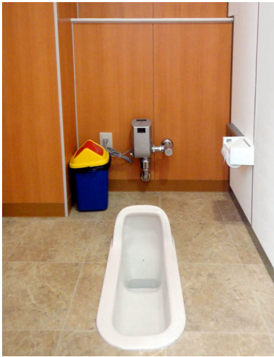
各トイレにセンサー式フラッシュバルブの和式便器を1ヶ所設置。節水効果の高い擬音装置「音姫」も取り付けられた。
