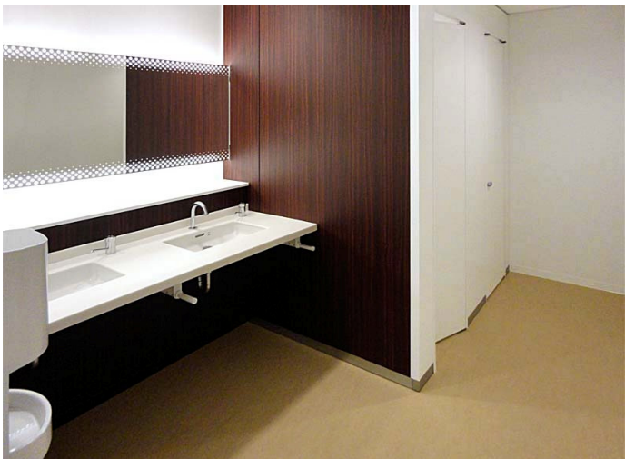
動線確保のため、大便器ブースの扉は手前側を内開き、奥側を外開きとした。荷物を持って移動することが多い学生のために、荷物配慮としてカウンター下にフックを設置。
