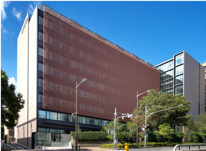
地下1階、地上9階の新2号館は、遮光効果・省エネ効果のあるテラコッタルーバーを外観に使用。
