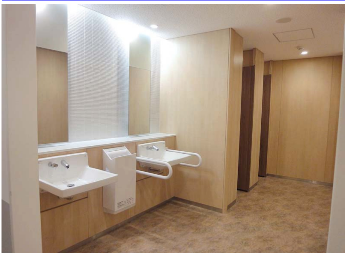
1F 男性トイレ 全体
