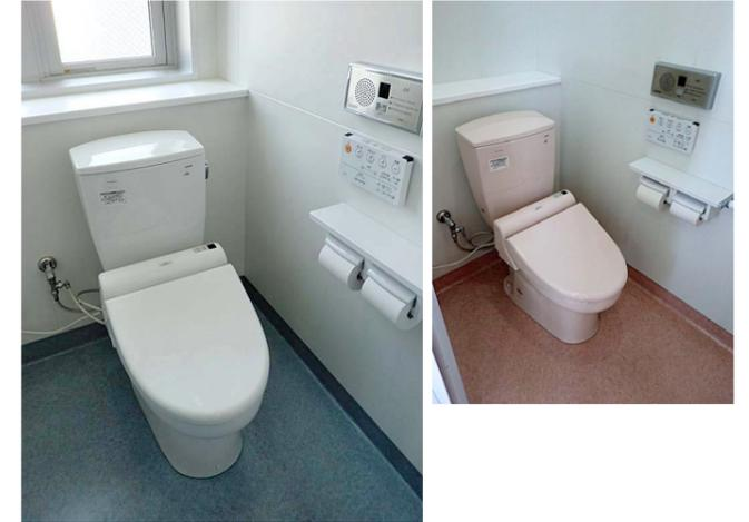
すべてのブースにウォシュレット、音姫（擬音装置）を完備。生徒の要望で1ヶ所ピンク色の便器を設置。紙巻器の上と便器後方に、手荷物が置ける棚を用意している。
