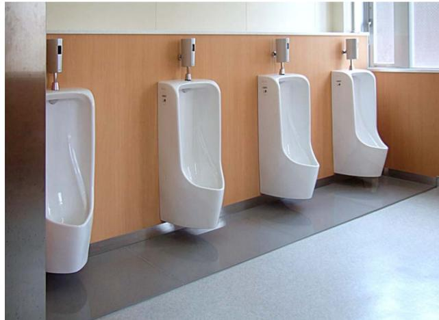
衛生的で節水効果も期待できる自動洗浄機能付きの壁掛式小便器を採用。足元には尿の飛散によるにおいや汚れを防ぐハイドロセラフロアを設置。
