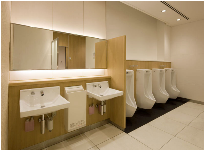
小さなお子様から大人まで使える低リップタイプの小便器。素早く手が乾かせるよう洗面器の間にクリーンドライを設置している。
