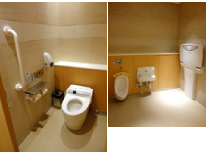
左)大便器は、ウォシュレット一体形便器ネオレストDタイプを採用。右)幼児用小便器・手洗器・ベビーシートを設置した親子配慮コーナー。
