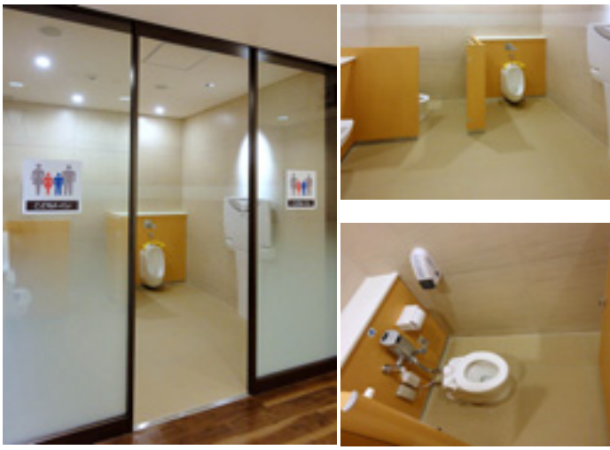
開放的なつくりの子ども専用トイレ。通路からトイレ内が丸見えにならず、かつ目が届きやすいよう、ガラスの下部をくもりガラスにしている。
