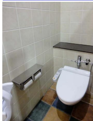
二度流しを減らすために、音姫(擬音装置)機能搭載のウォッシュレットPを採用。ライニング上部は荷物棚として利用できる。
