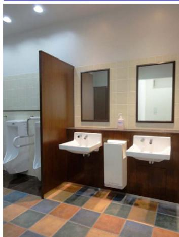
手洗い後の水でカウンターや床が濡れないように、奥行き約30cmのライニングカウンターを設け、洗面器の間に温風乾燥機を設置している。
