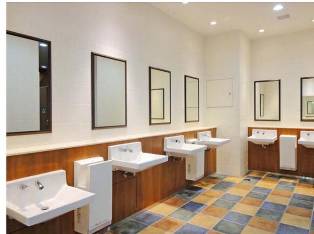
買い物袋を安心して置ける奥行き約30cmのライニングカウンターと床の水濡れ防止のため、洗面器の間に温風乾燥機を配置。洗面器の1ヶ所は、お子様の使いやすさを考慮して低めに設置している。
