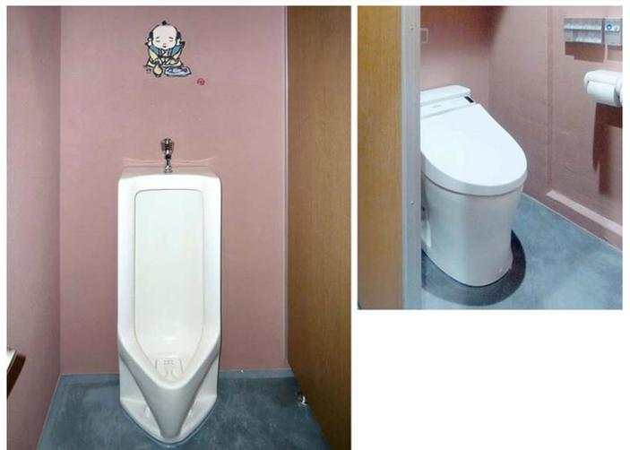
トイレの内装を明るく一新。大便器は、節水性とデザイン性に優れた4.8L洗浄のパブリックコンパクト便器フラッシュタンク式を採用。便座はウォシュレットPSを設置し、電源不要のエコリモコンを取り付けている。
