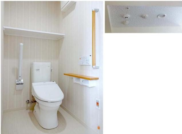
安全配慮として、座位の安定や立ち座りをサポートする、はねあげ式手すりと縦手すりを設置。さらにトイレ入口の居室側の天井には安否確認センサーを設置している。
