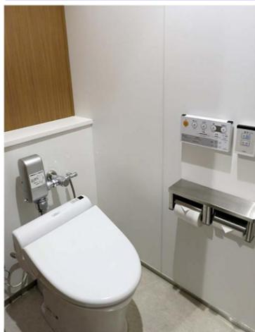
環境に配慮して、オート洗浄タイプの節水便器を採用。2度流しを防止するため、音姫(擬音装置)機能を搭載したウォッシュレットも設置している。
