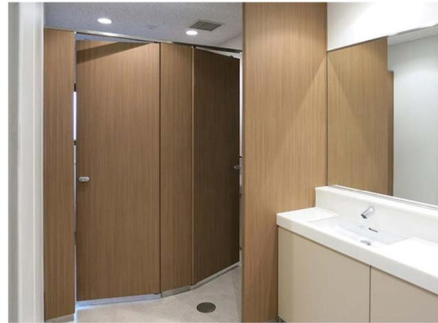
使用されていないときは、大便器ブースの扉が15°の角度で止まるように設定。大便器ブースの内部が丸見えにならず、空き状況もひと目で確認できる。
