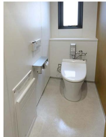
大便器ブースの1ヶ所には、ストッキングの履き替えなどができるフィッティングボードを設置。大便器後方の棚や紙巻器の上は、荷物置きとして利用できる。
