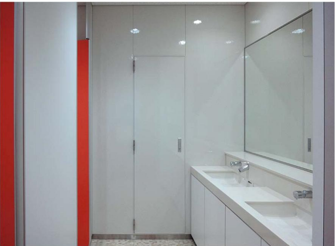
基準階 女性トイレ 洗面コーナー
