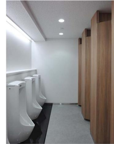
床の清掃性に優れた低リップタイプの壁掛小便器を採用。小便器コーナーにも間接照明を用い、落ち着いた雰囲気を出している。
