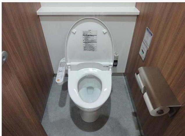
大便器ブースの間仕切り壁を天井まで立ち上げ、個室感を高めている。2度流しを減らすための擬音機能付きのウォシュレットとセンサーによる自動洗浄機能を採用。大便器後方の棚には荷物を置くことができる。
