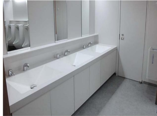
カウンターと洗面ボウルを一体成形した、清掃性に優れたボウルー一体タイプのカウンターを採用。ノンタッチで水や水石けんの出し止めができる、自動水栓とオートソープディスペンサーを設置している。
