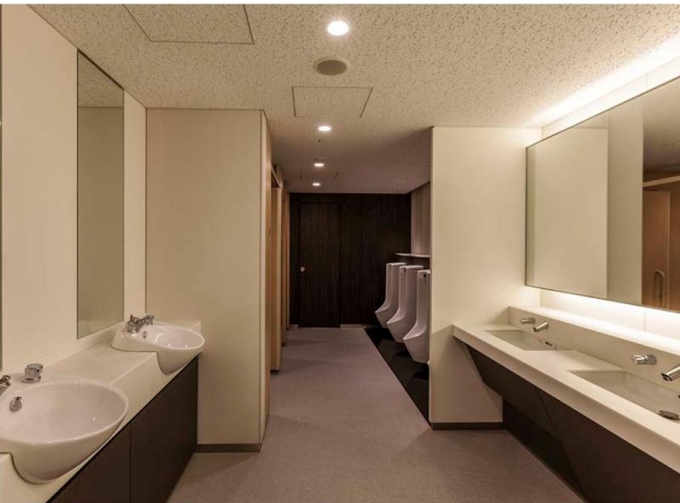
洗面コーナーは、カウンター下のパネルを斜めに取り付け、車いす使用者がアプローチできるようにしている。洗面コーナーの対面には、歯みがきコーナーを設置。
