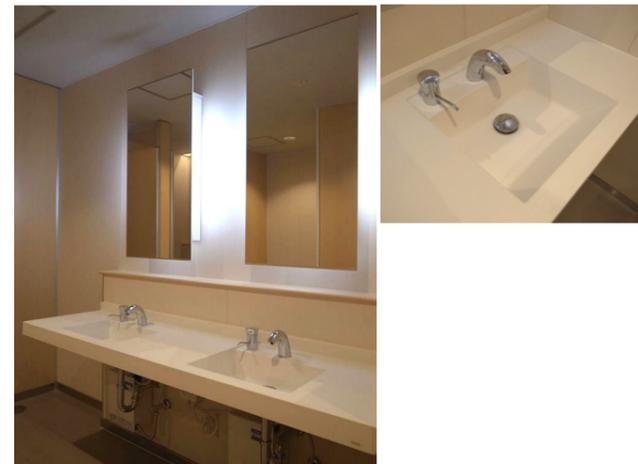
カウンターとボウルとの間に継ぎ目がなく、清掃性に優れたボウル一体タイプの洗面カウンター。水栓金具は、ノンタッチで水の出し止めができる自動水栓を採用。
