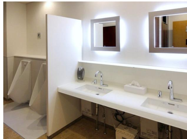
電気温水器付きの自動水栓を採用し、冬場でも快適に手洗いができるように配慮している。
