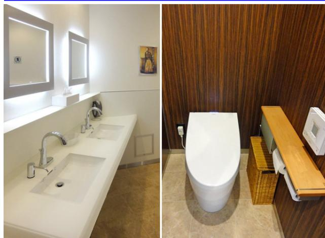
手動と自動、湯と水の使い分けができる自動水栓は社員にも好評。大便器は、シンプルなデザインのネオレストAHタイプを採用。4.8L洗浄で節水性にも優れている。
