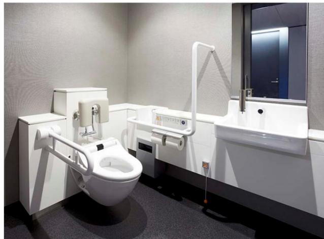
基準階にはRESTROOM ITEM 01のフラットカウンター多機能トイレパックを採用した多機能トイレを1ヶ所設置。オストメイト対応として、パウチ・しびん洗浄水栓付背もたれ(特殊品)を取り付けている。
